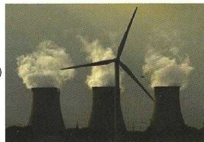
Eolienne et sa « roue de secours »
