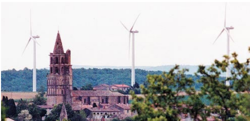
Höher als die Kirche von Avignonnet – die Montage wagt den Beweis. Fotos: Vent de Colère; Fayolle/Sipa
