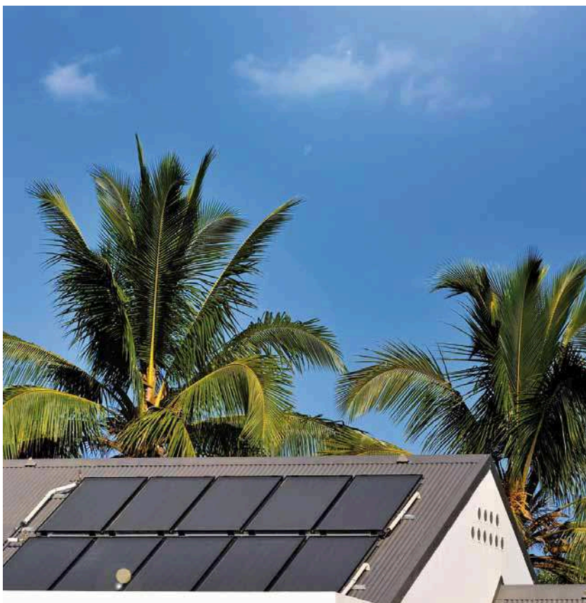
Panneaux photovoltaïques à La Réunion. Dans les principales collectivités d'outre-mer et en Corse, la capacité de production en attente de raccordement au réseau excède la demande locale en électricité. Le seuil de 30 %, limite réglementaire d'acceptabilité technique des énergies intermittentes relative à la stabilité des réseaux, sera à court terme dépassé.
